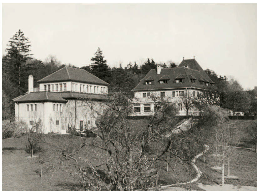
Villa Am Römerholz avec galerie de peintures attenante, construite en 1913-1916 d'après les plans de Maurice Turrettini, photographie de Hermann Linck, Winterthur, vers 1950, Archives de la Collection Oskar Reinhart « Am Römerholz », Winterthur
